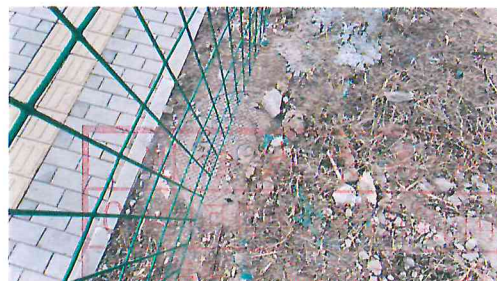
项目内燃气井
