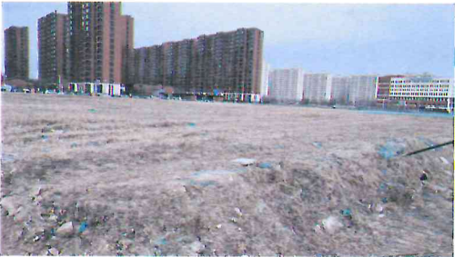
项目内地面平整情况
