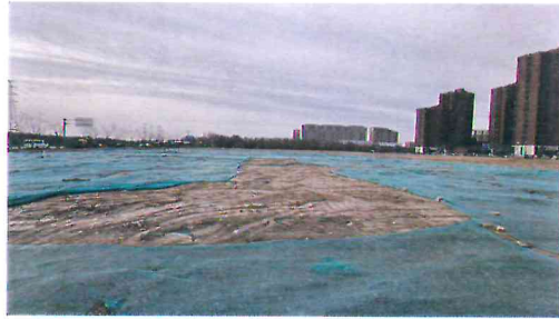
项目内地面平整情况
