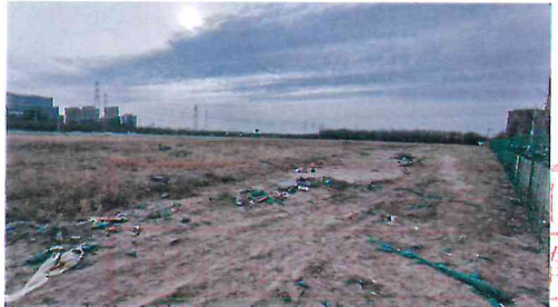
项目内地面平整情况
