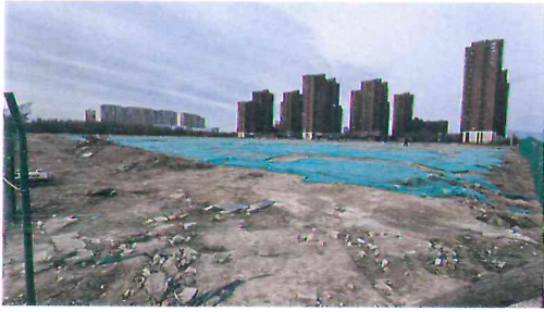
项目内地面平整情况
